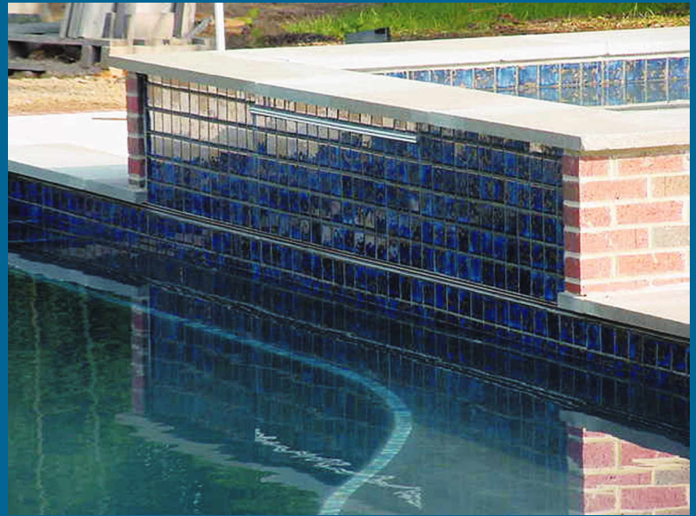
Receptor en muro con pared lateral alzada y muro lloron
